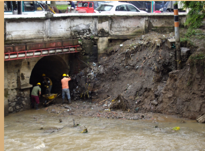
Trabajadores despejando lodo. Puente del río Molino, inundación 2011. Foto 8: Alejandro Luna F.
